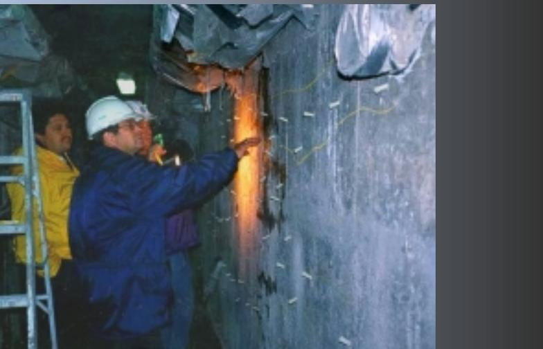
pour ce projet, a mis au point un modèle d'analyse par la méthode des éléments finis qui évalue les dommages et prédit la détérioration future. Les travaux de réhabilitation pourraient éventuellement prolonger de 100 ans la vie utile des écluses de la région Maisonneuve.
