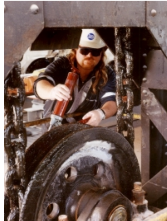
Dave Berry, préposé à l'entretien, graisse les roues qui ouvrent les portes de l'écluse 5 du canal Welland
