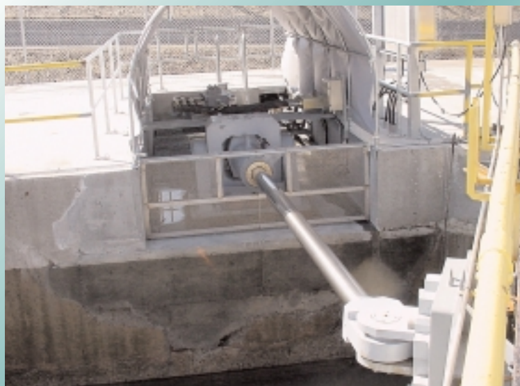
Un nouveau cylindre hydraulique à la porte 4 de l'écluse 7. (Photo Iqbal S. Biln)
