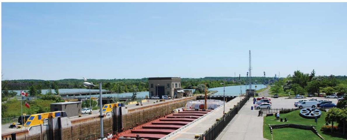
Navire maintenu par AML (aucun câble d'amarrage requis) dans l'écluse 3 du canal Welland
