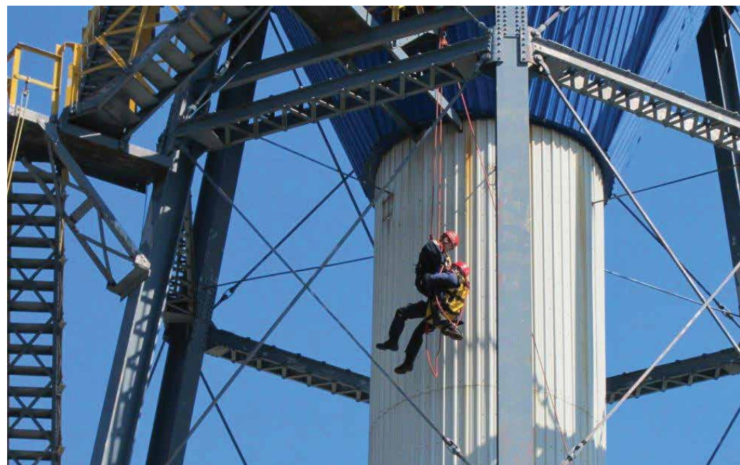
Le Service d'incendie de St. Catharines a réalisé un exercice de sauvetage en hauteur en mai 2014 (au château d'eau situé à l'écluse 4 du canal Welland).
