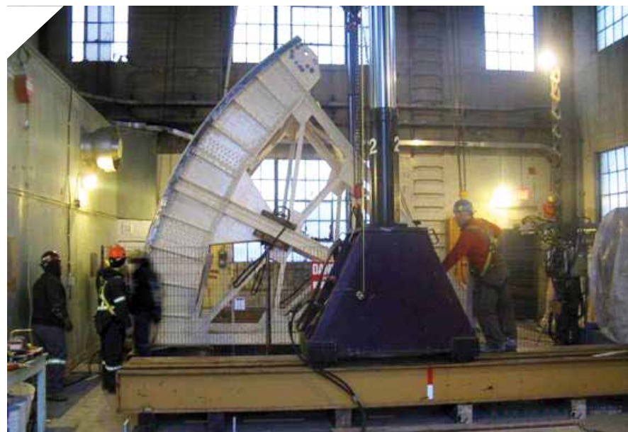
Réinstallation d'une vanne d'écluse après sa remise en état.
