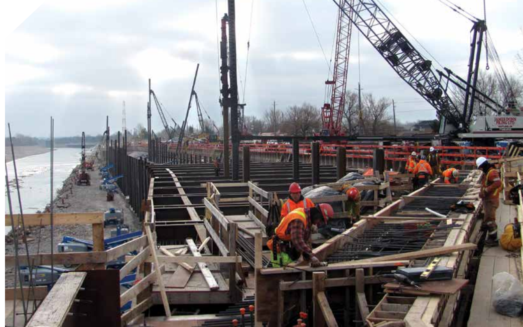
Vue du mur d'approche à l'extrémité supérieure de l'écluse 1 en construction (hiver 2015).
