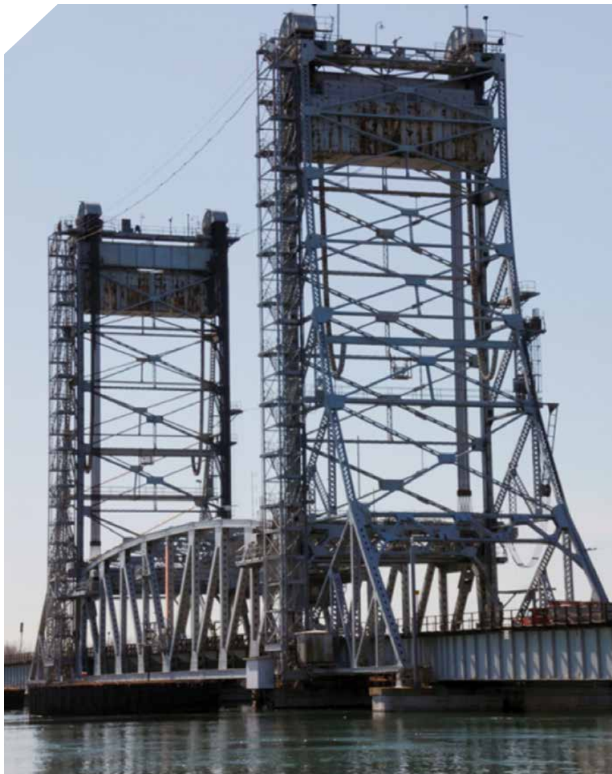
Le pont de Valleyfield.
