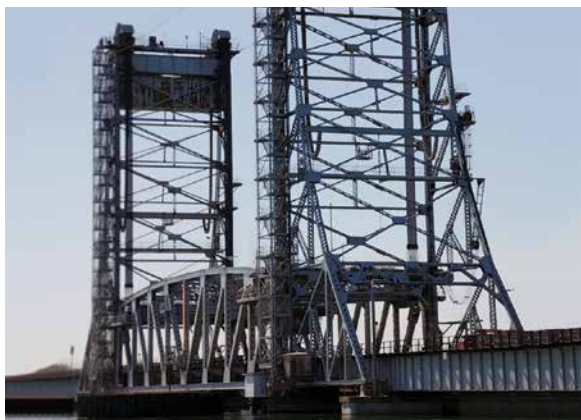
Les tours du pont de Valleyfield
