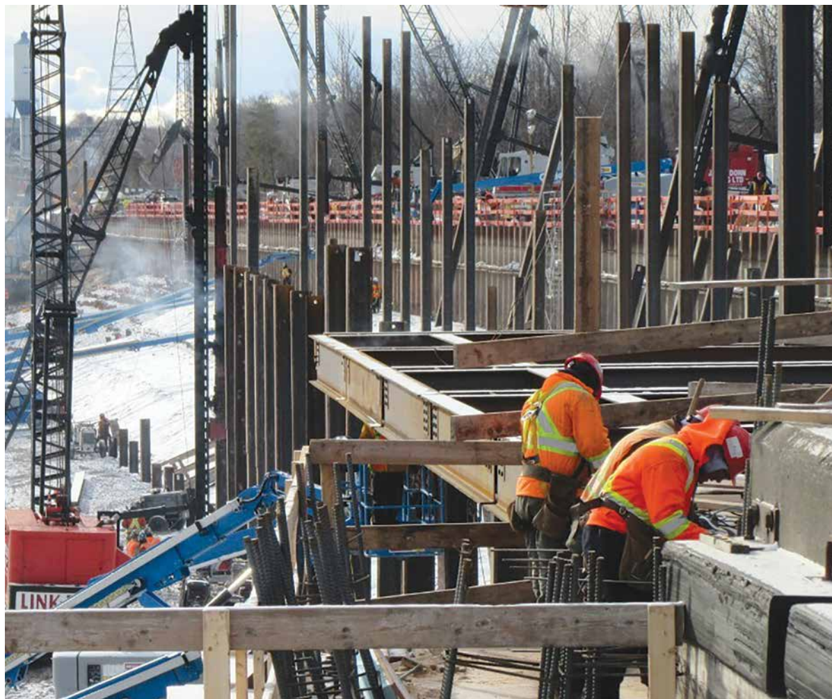
Vue du mur d'approche à l'extrémité supérieure de l'écluse 3 (en construction, à l'hiver 2016)
