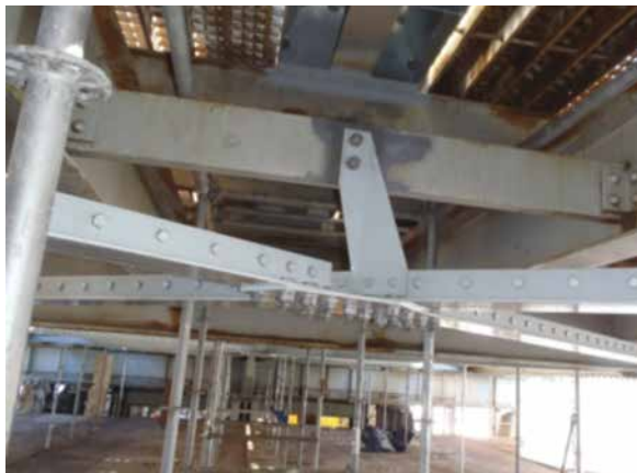
Réparations en cours à la structure d'acier au pont 3
