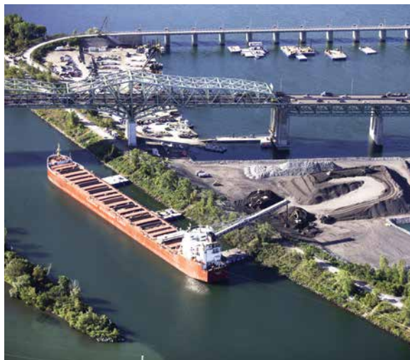
Un autodéchargeur livre de la pierre concassée au chantier du nouveau pont Champlain de Montréal.
