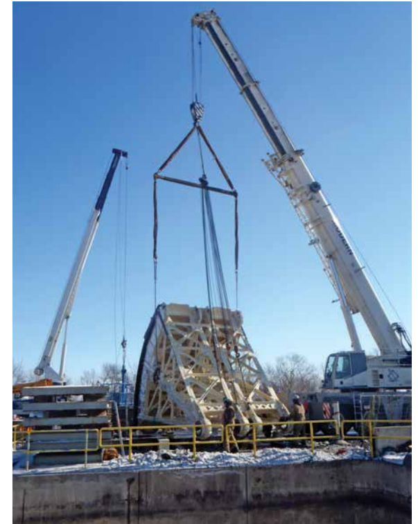
Installation de la vanne remise en état dans le puits de vanne
