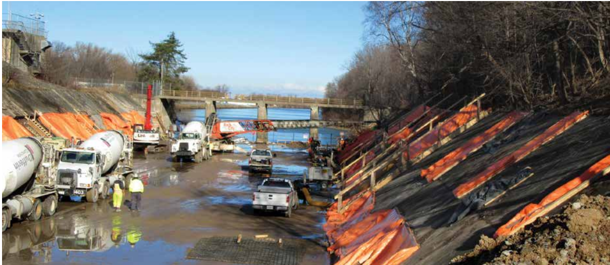
Réparations en cours au déversoir 1 (côté est du bassin)
