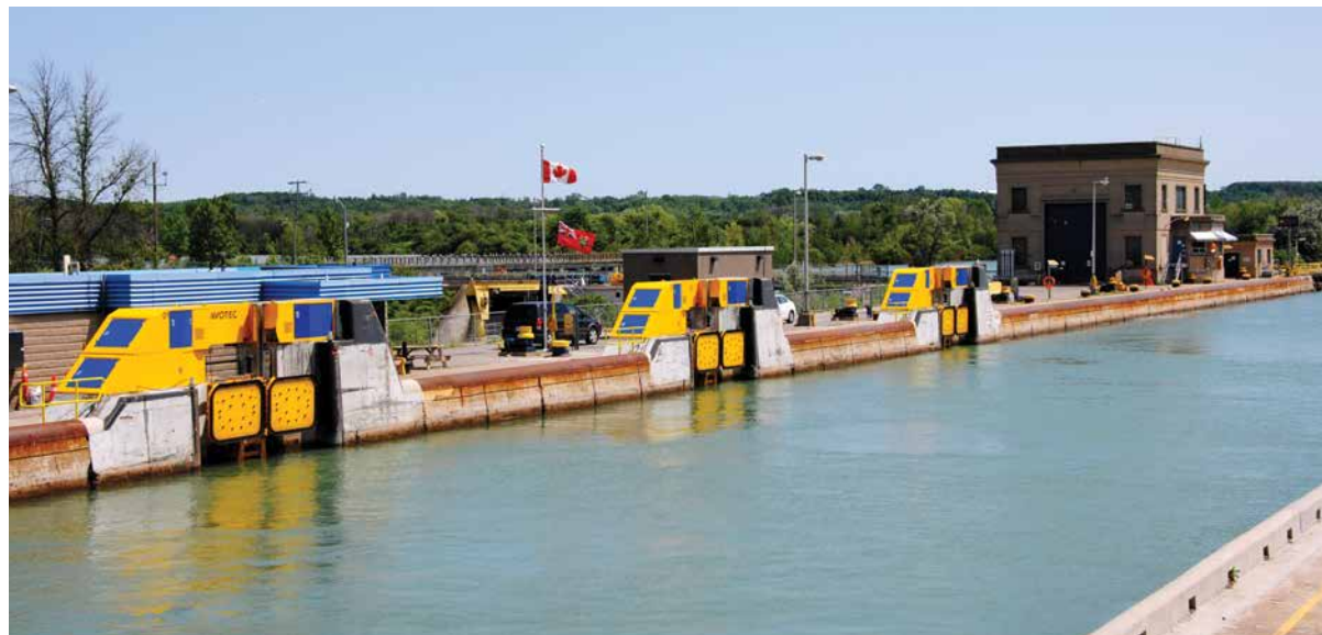
Ventouses d'AML prêtes à amarrer un navire à l'écluse 3 (canal Welland)
