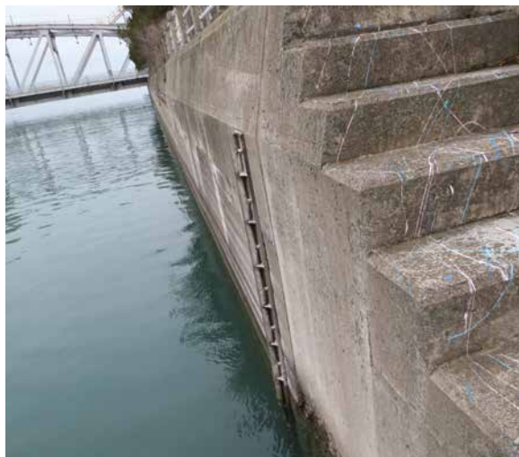
Exemple d'ancrage de barrage de rétention d'hydrocarbures posé dans le canal Welland
