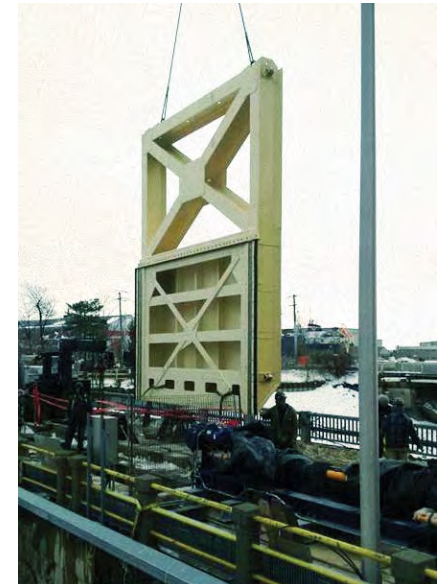
Déversoir 2 : Remise en état et remplacement de vannes et du mécanisme d'entraînement
