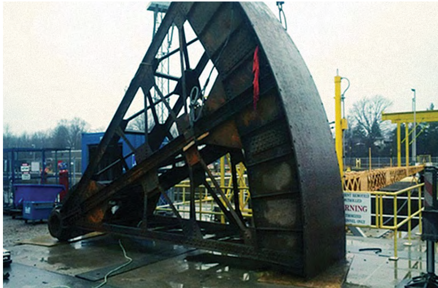
Écluses 5 et 6 – Renouvellement du revêtement et remise en état des joints latéraux et des tourillons des vannes 1 et 2
