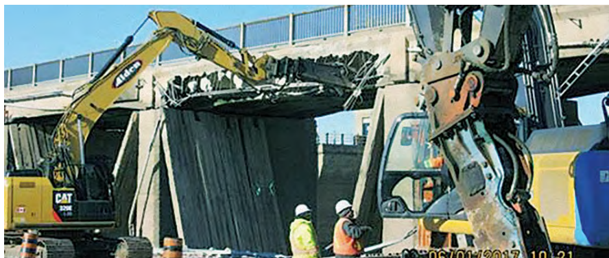
Pont 3A de la rue Carlton – Démolition et remplacement de la travée d'approche fixe
