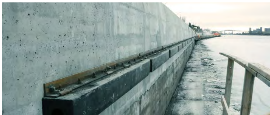
Réparations au mur d'approche de l'écluse de Saint-Lambert
