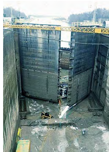
Écluse 1 – Remplacement de la poutre de l'épaulement du pivot des portes 1 et 2
