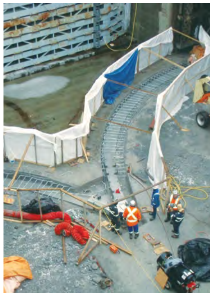
Nouvelle voie de roulement pour les vannes à secteur de l'écluse d'Iroquois
