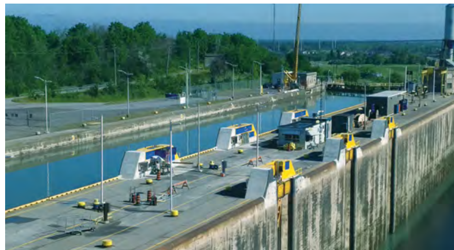
Dispositif d'amarrage mains libres aux écluses en paliers (canal Welland)
