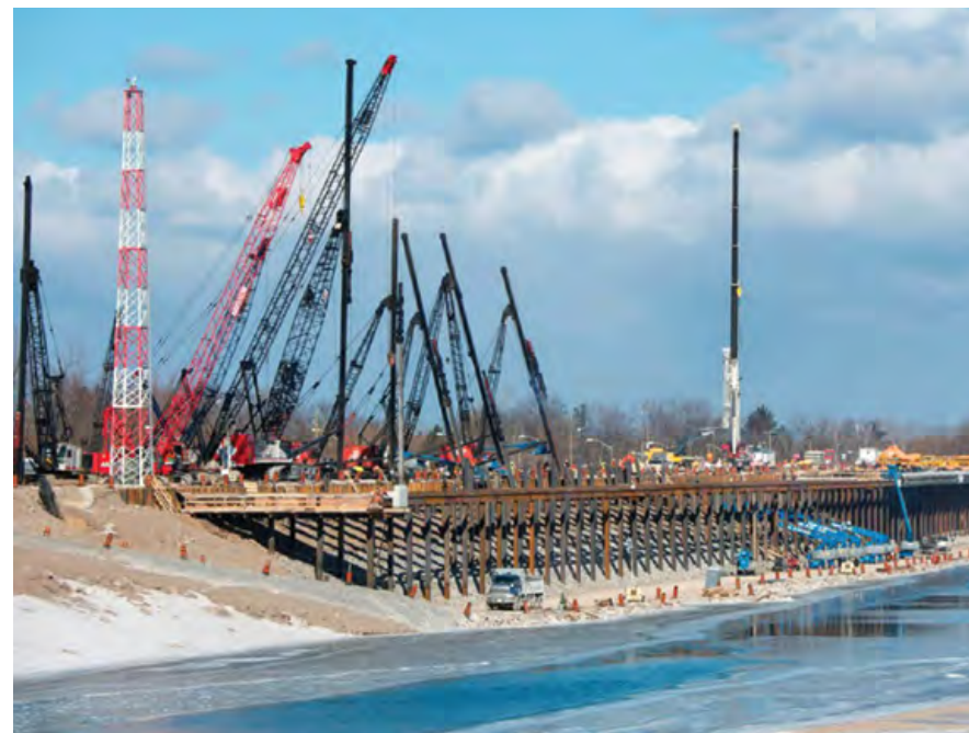
Photo d'une partie des 1,9 km de murs d'amarrage du canal Welland au cours de la reconstruction
