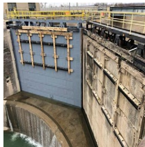
Écluse 2 - Revêtement de la porte busquée 3 – Réparation structurale et revêtement intérieur et extérieur. Intérieur de l'enceinte pendant les travaux d'hiver
