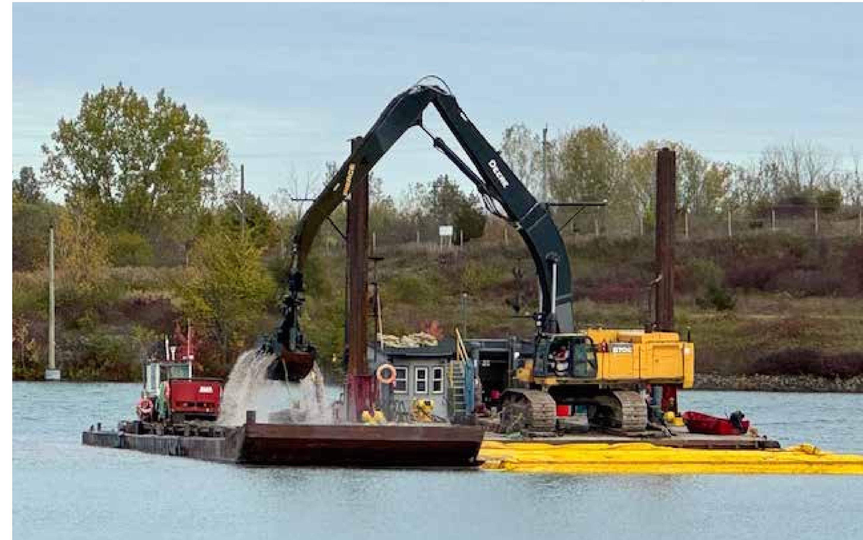
Travaux de dragage au quai 10, canal Welland
