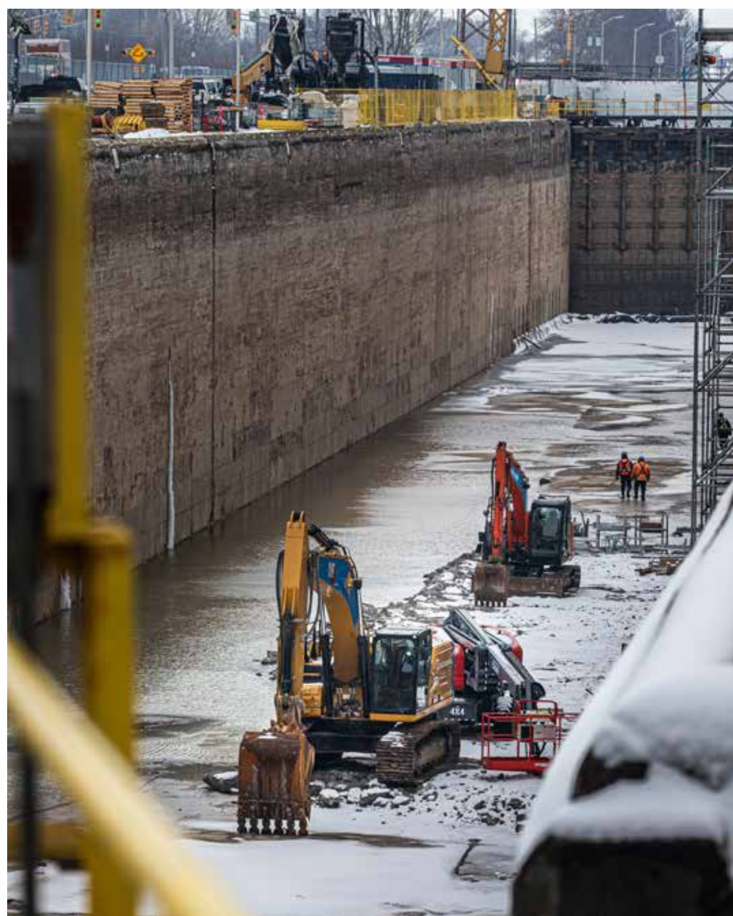
Travaux de réparation de l'écluse 8, canal Welland
