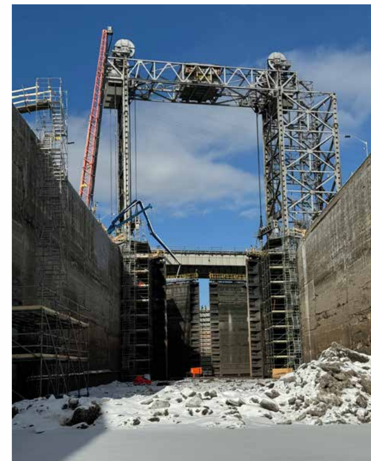
Travaux de remise en état à l'écluse de Saint-Lambert
